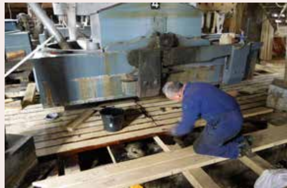
2011 Bij het funderingsherstel van De Schoolmeester in 1967 werd ook een nieuwe vloer gelegd. Na veertig jaar had die ook zijn beste tijd gehad. Niet alleen de vloer werd vervangen, maar ook de balken en de onderslagen. Arie Butterman voerde deze klus vrijwel in zijn geheel zelf uit.
