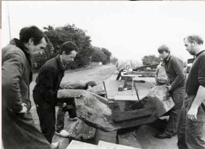
1985 De oude penbalk van De Schoolmeester die werd teruggeplaatst in de nieuwe kap van de molen. Op de achtergrond is smid Venema bezig met het repareren van de buitenroed.
