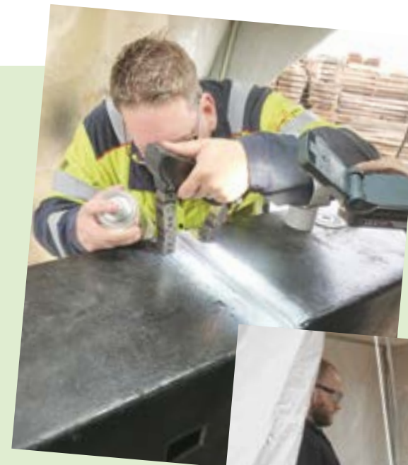
3. De lassen worden op scheurtjes gecontroleerd
