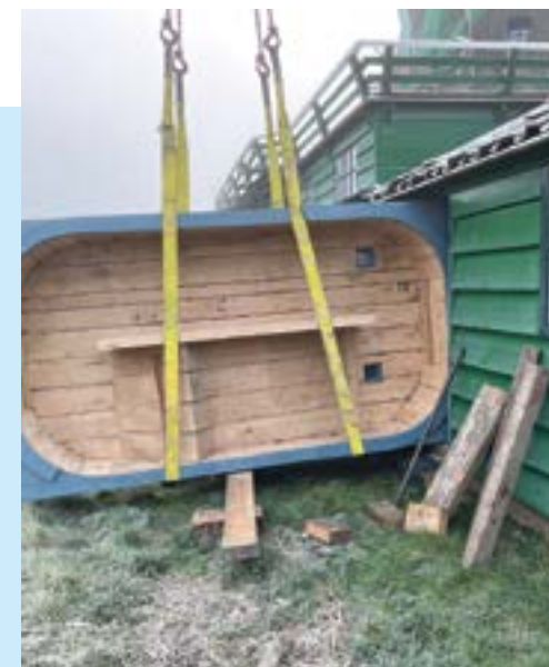
Het binnen brengen van de roerbak met onder en boven 1 cm ruimte
