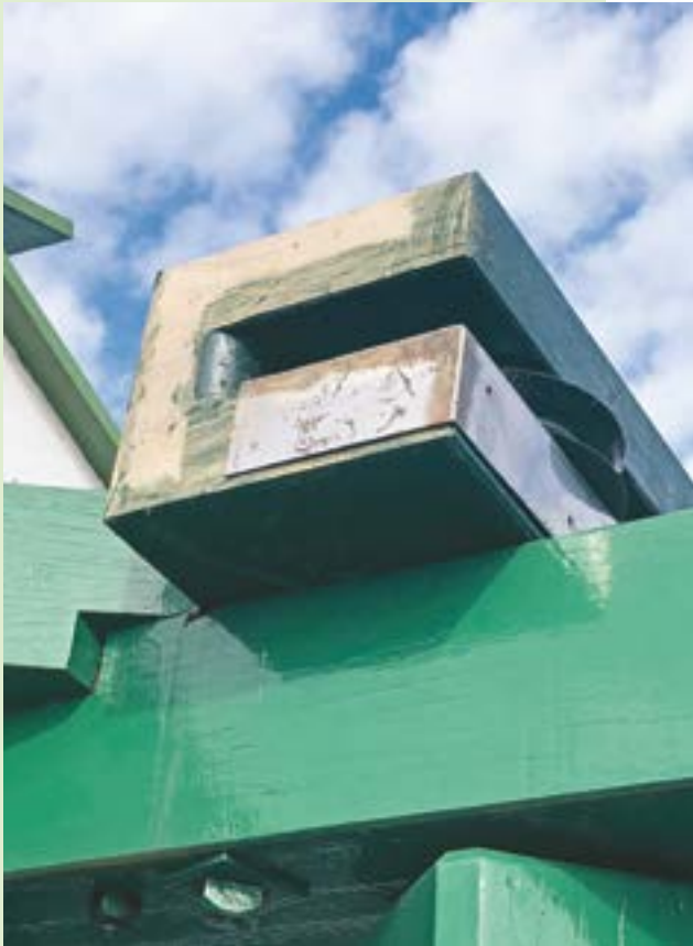
Het nieuwe blok op z'n plaats
