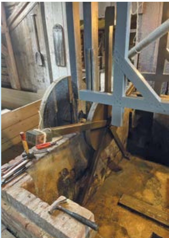
Het scheprad in reparatie
