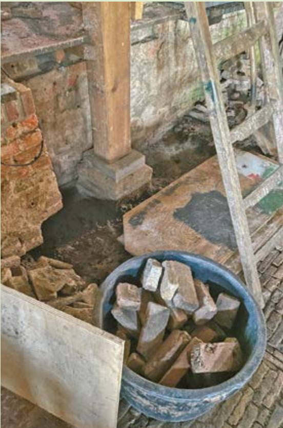
Centraal op de foto: de stijl hangend aan de legering, welke wordt ondersteund door twee dommekrachten
