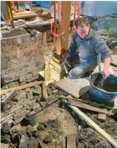
Oud bovenstuk van penant 1973 hangt aan de rode banden, Ron metselt laatste kier dicht
