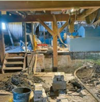
Centraal op de foto: de stijl hangend aan de legering, welke wordt ondersteund door twee dommekrachten
