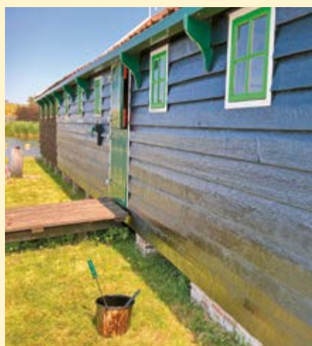
Teerwerkzaamheden aan de molen
